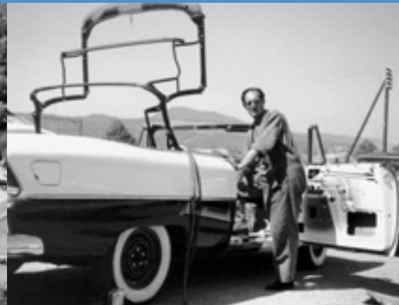
Montaggio di una capote.
